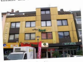
Abb. 18: Fassade am Angoulemeplatz
