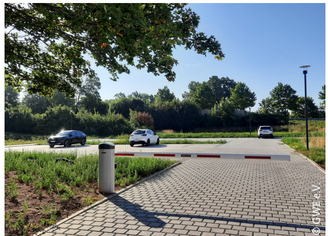
Anstelle des Garagenhofs ist die Stellplatzanlage entstanden.
