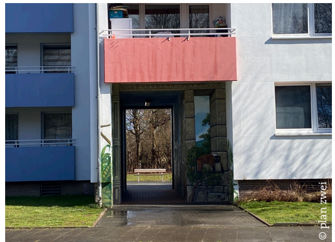
Durchbruch und Wegeabkürzung am „D-Zug“.
