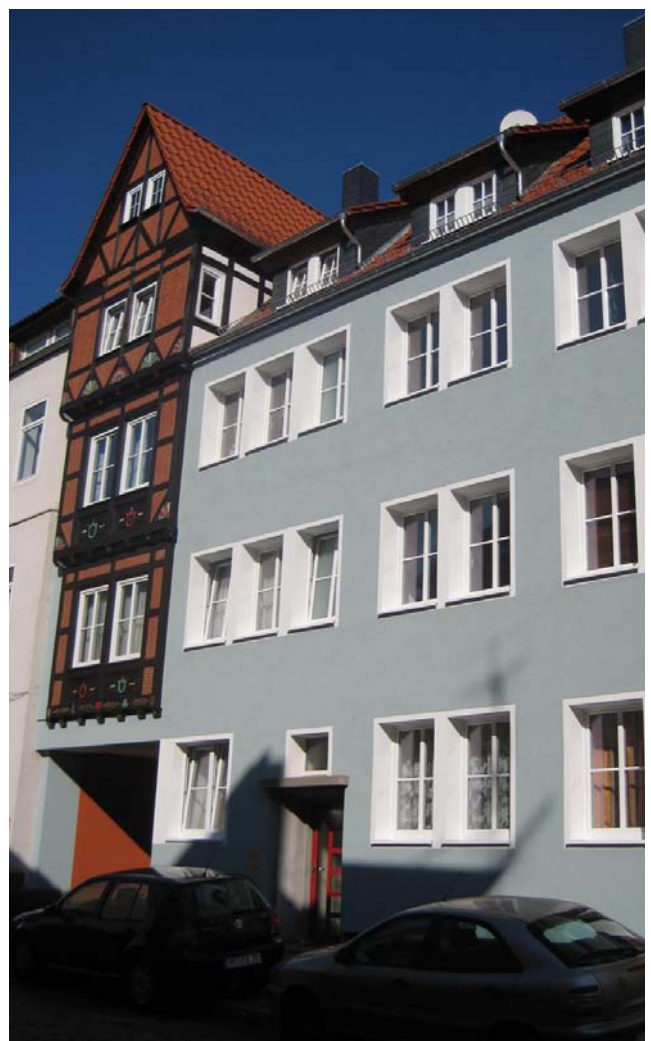
Fassade nach der Sanierung
