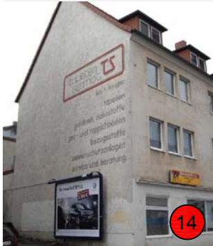
Fassade vor der Sanierung
