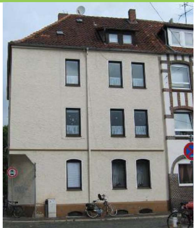
Fassade vor der Sanierung
