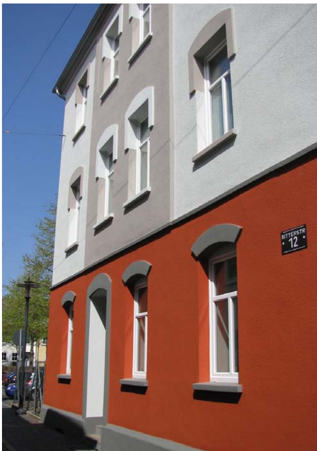
Abb. 5: Erste fertiggestellte Stadtumbaumaßnahme
