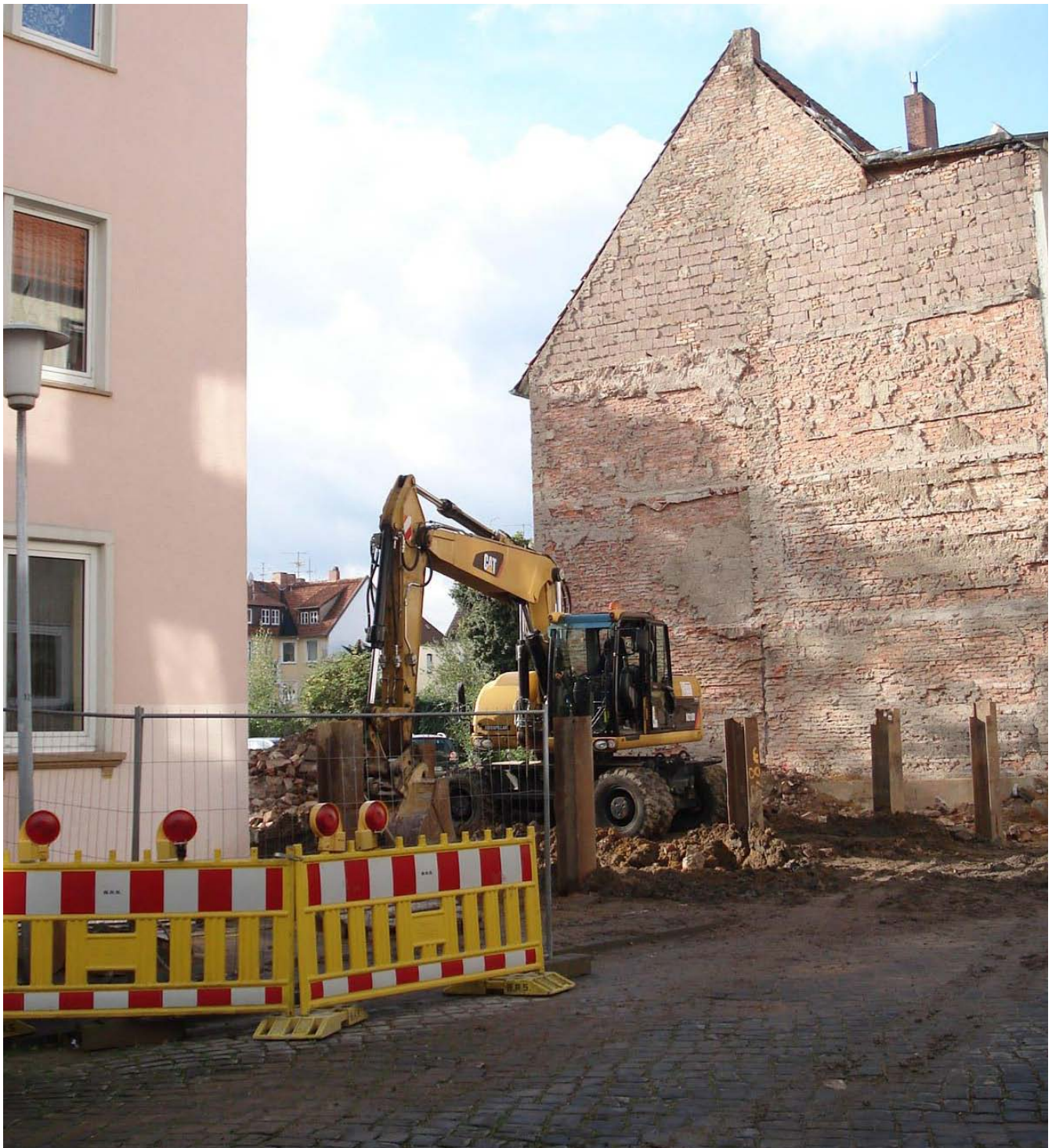
Abb. 53: Abrissarbeiten im Michaelisviertel
