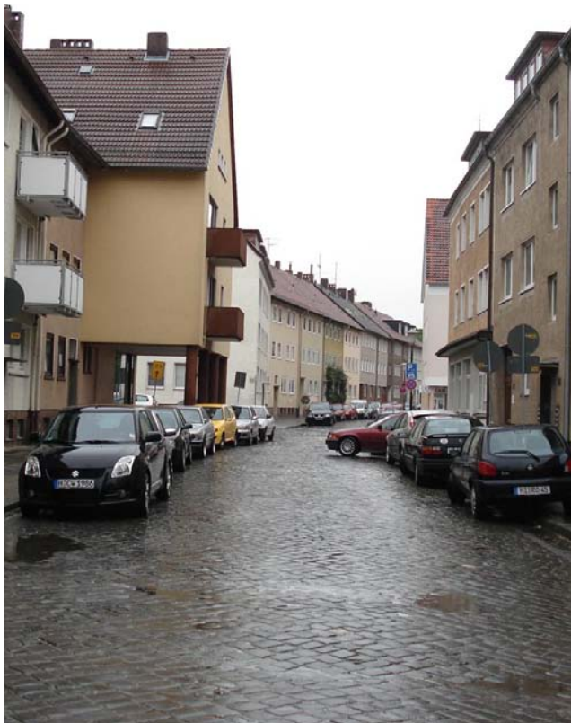
Abb. 44: Erforderlichkeit zur Sanierung der Straßenräume zur Steigerung der Lebens- und Aufenthaltsqualität
