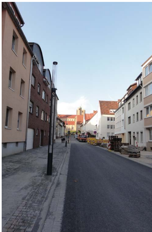
Abb. 66: Umbaumaßnahmen in der Burgstraße kurz vor der Fertigstellung
