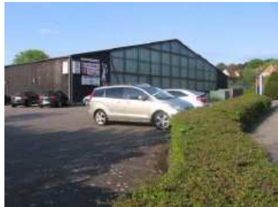
Tennishalle und Parkplatz
