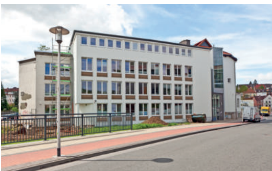
Saniertes Gebäude Phoenixstraße 3
