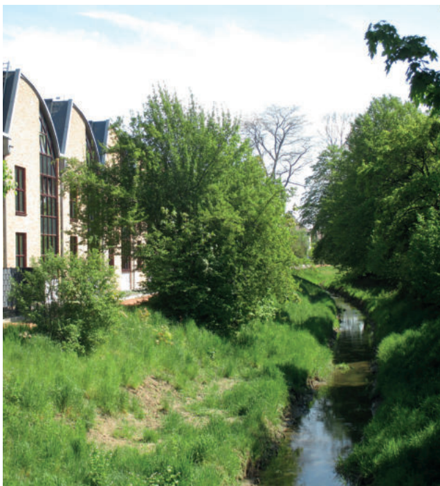
Sanierte Paschenhalle mit Kupferstrang
