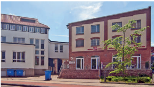
Saniertes Gebäude Phoenixstraße 5
