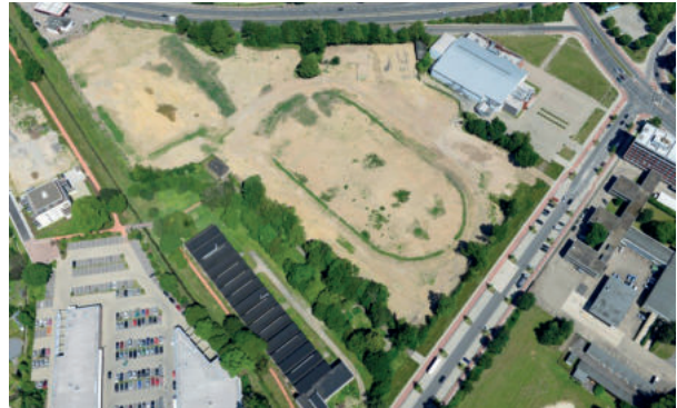
Luftbild Sportplatz nach Sanierung
