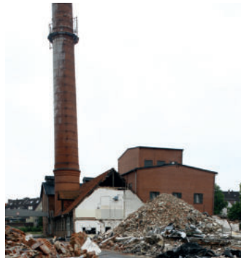
Schornstein während der Umbauphase
