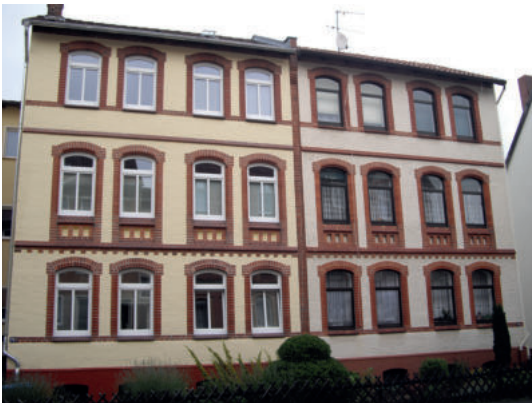
Saniertes Gebäude Maschstraße 78
