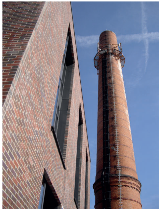
Neubau Phoenixgelände mit Schornstein
