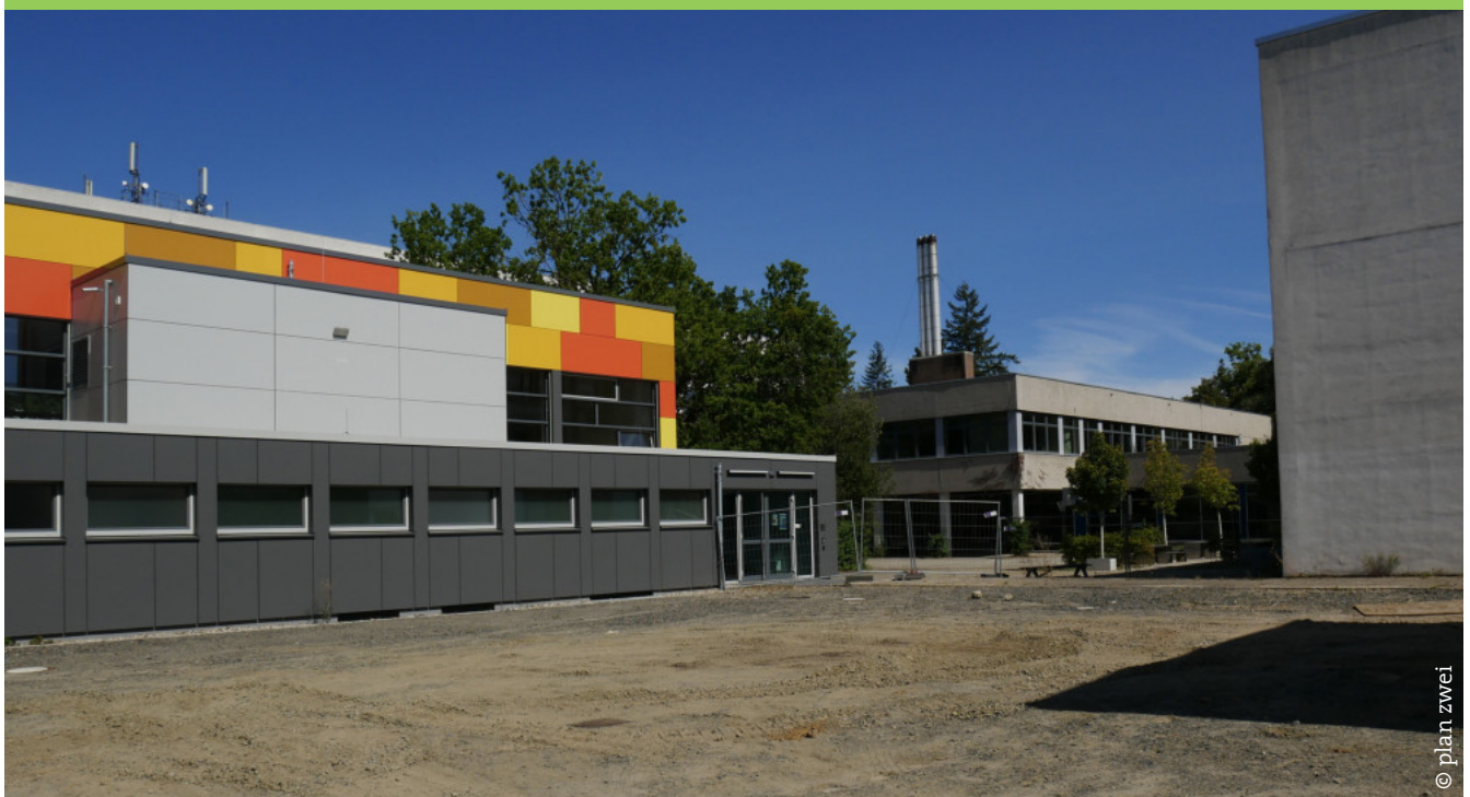
Die Multifunktionshalle ist durchs Schulgebäude oder von hinten (über die Zufahrt zum TZH) erreichbar.
