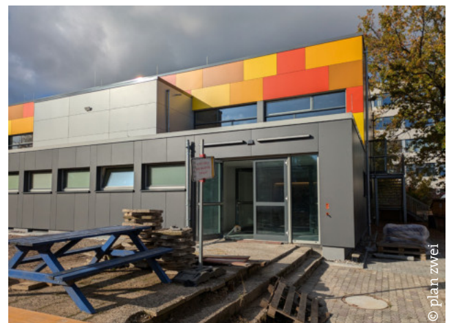
Eingangsbereich zur Halle während des Umbaus
