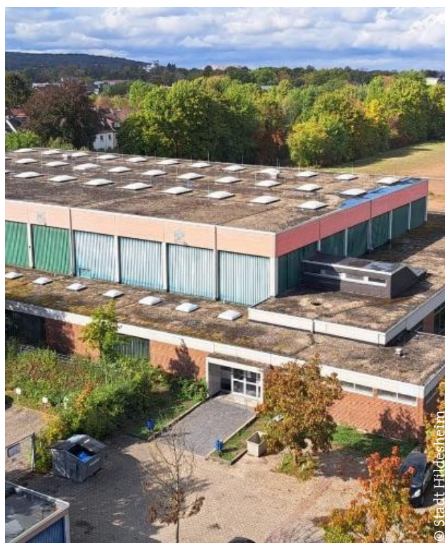
Die Vier-Feld-Sporthalle hat erheblichen Sanierungsbedarf.
