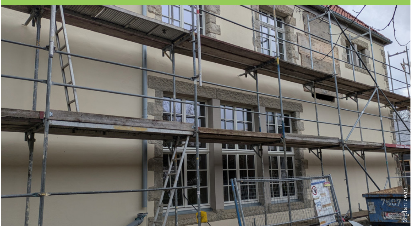
Die neuen Sprossenfenster des Martin-Luther-Gemeindehauses entsprechen den Denkmal- und Wärmeschutzanforderungen.
