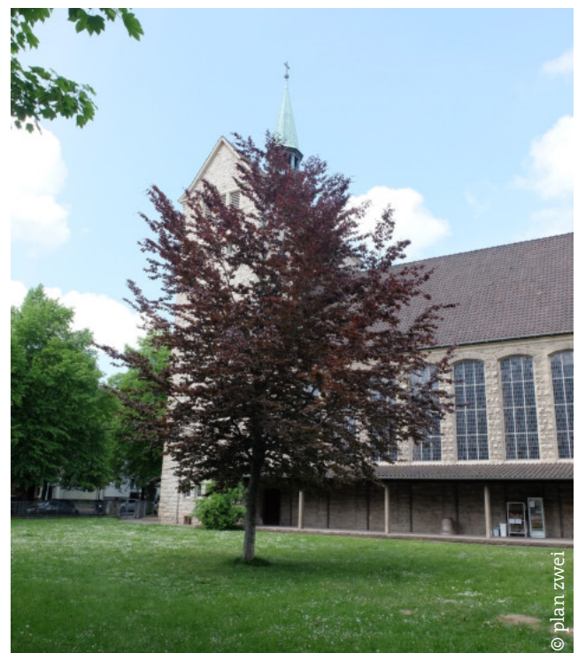
Das Kirchendach wird zukünftig saniert werden.
