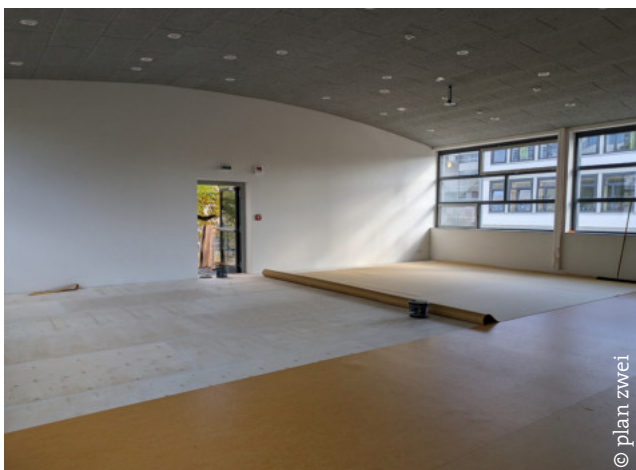
Verlegen des Turnbodens im oberen Raum
