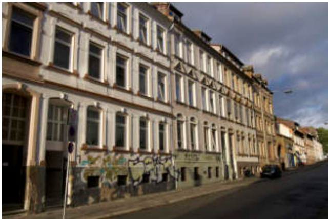
Abb. 77: Butterborn mit Sanierungs- und Entsiegelungsbedarf
