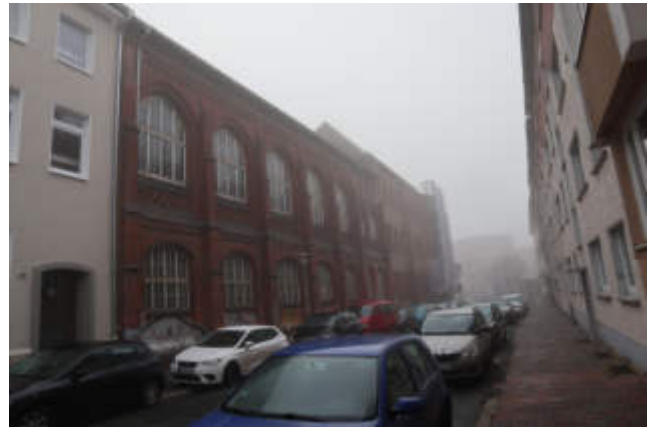
Abb. 78: Lüntzelstrasse mit Sanierungs- und Entsiegelungsbedarf
