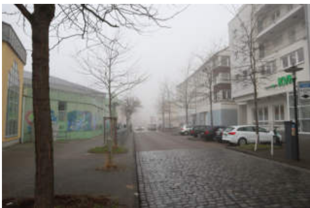
Abb. 96: Hannoversche Straße mit Sanierungsbedarf
