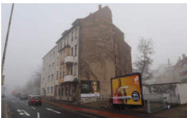
Abb. 100: Baulücke an der Marie-Wagenknecht-Straße
