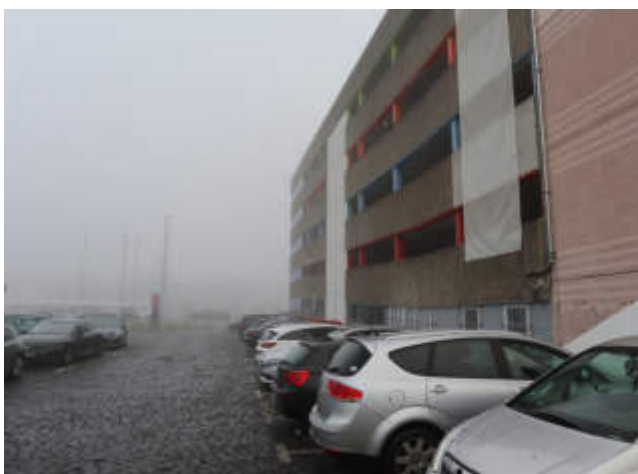
Abb. 138: Parkplatz beim Parkhaus Rose
