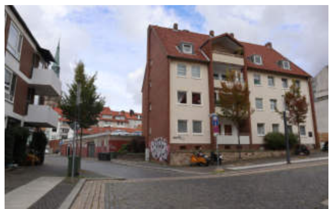
Abb. 135: Kreuzstrasse Blick zum Parkdeck am Kläperhagen
