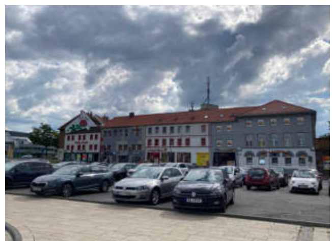
Abb. 139: Parkplatz am ZOB, Blick nach Westen
