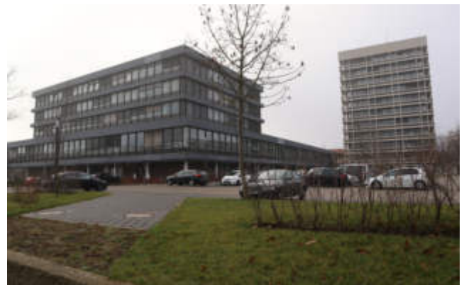
Abb. 86: Gerichtsgebäude am Innenstadteingang Ost
