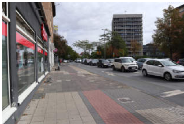
Abb. 97: Sanierungsbedarf Bodenbelag entlang der Kaiserstraße
