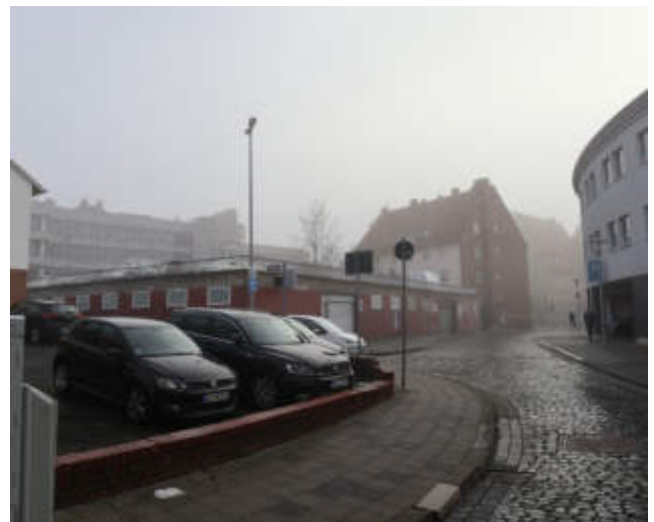
Abb. 143: Parkplatz, Parkdeck am Kläperhagen
