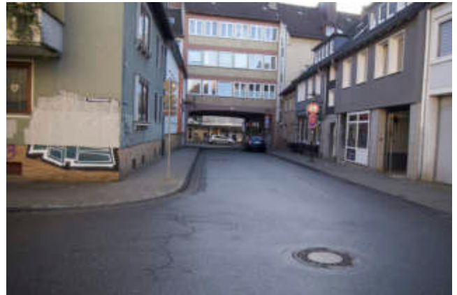
Abb. 129: Sanierungsbedarf südlicher Teil Am Ratsbauhof
