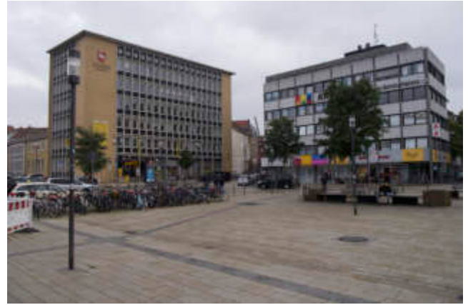
Abb. 91: Hochpunkte um den Bahnhofsvorplatz
