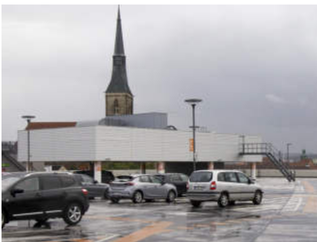
Abb. 167: Aussichtspunkt auf dem Dach der Arnekengalerie
